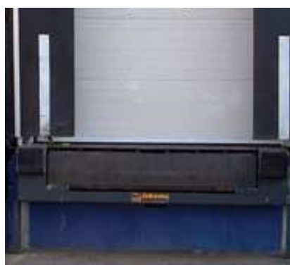
Minirampa en un muelle de carga.
